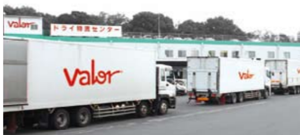
パロー物流センター（岐阜県多治見市）
