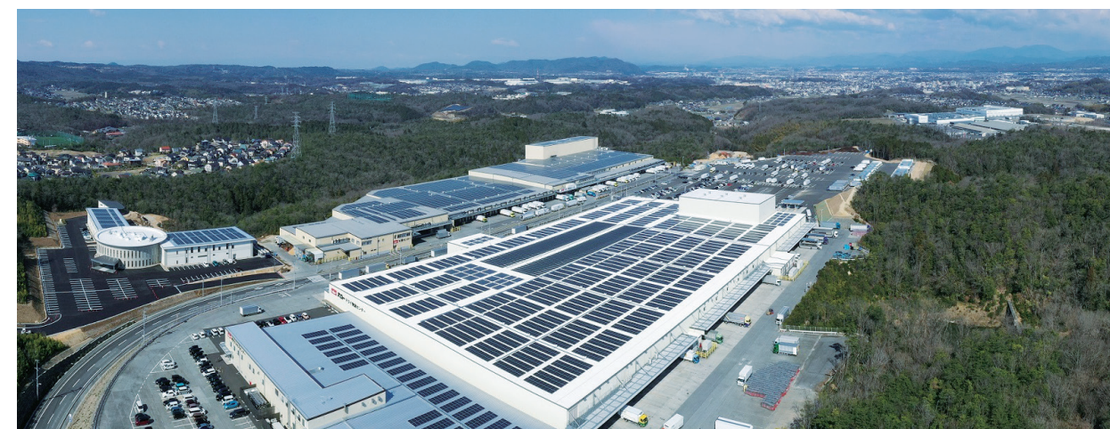
屋根に太陽光パネルを設置している人材開発センター。グループ全体で再生可能エネルギーへの取り組みを進める
